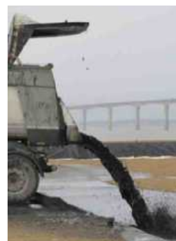
Les premiers déversements de sédiments au centre de valorisation. PHOTO « SUD OUEST »
